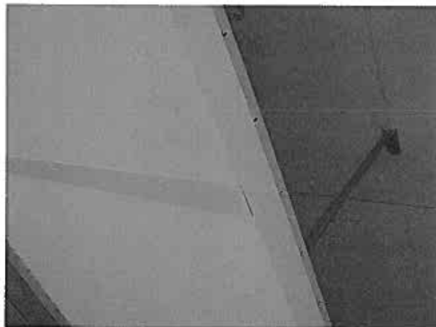
Deel van het opgehangen plafond (dragende constructie + plafondtegels).
